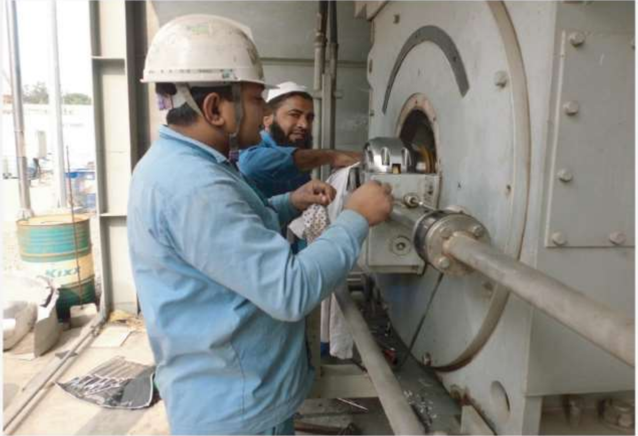
হরিপুর ৪১২ মেগাওয়াট কন্ডাইন্ড সাইকেল পাওয়ার প্ল্যান্টে ফিড ওয়াটার পাম্প মোটর বিয়ারিং মেরামত
